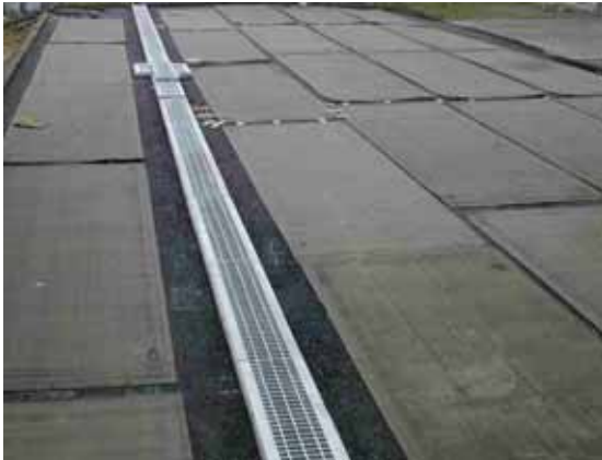
「スノーMZ システム」施工例
