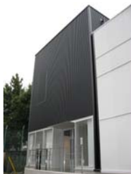
技術研究所遠心実験棟
