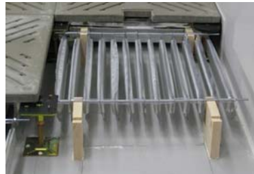
PCM 蓄熱材設置状況 (施工中)
