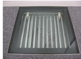
PCM 蓄熱材設置状況 (完成)
