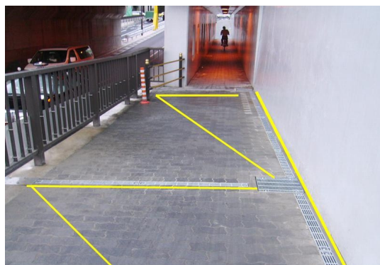
歩道補修工事 完成状況(設置位置入り)
