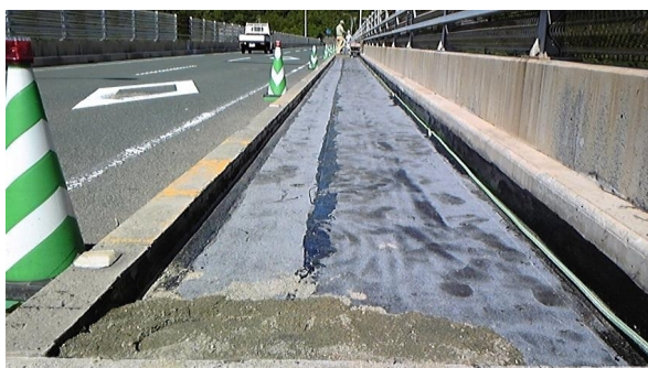
防水層上の排水対策クラドリップ設置
