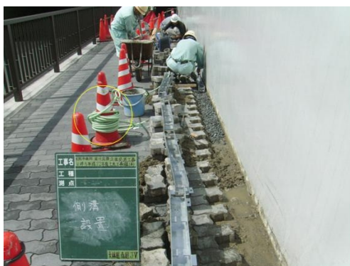
歩道補修工事 施工状況
