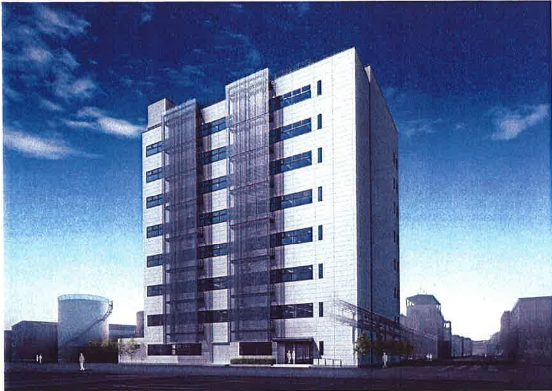
旭化成ケミカルズ 川崎イノベーションセンター 外観
