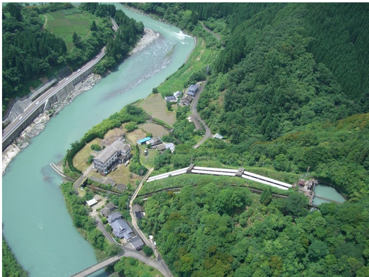
【写真2：川辺川第二発電所 航空写真】
