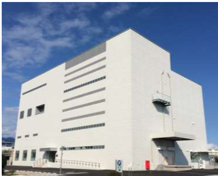
富士医薬工場医薬棟 外観
