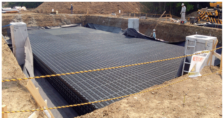
施工現場写真
