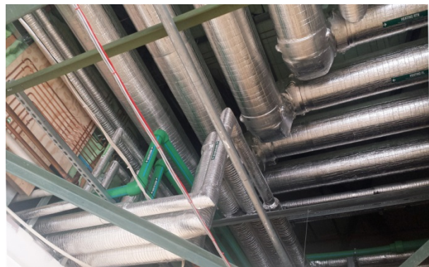
空調・給湯配管向け断熱材(製品名:サーモブレイク)の使用例
