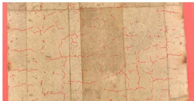
画像をアップロードすることで、幅0.1mm以上のひび割れを検出(赤線部分)
