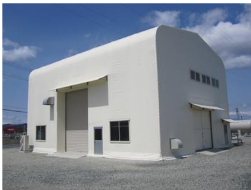
大型アルカリ水電解試験棟
