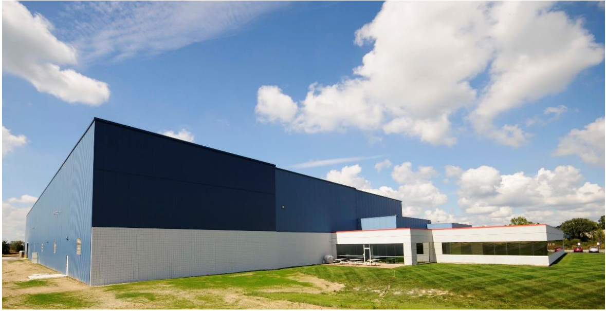
拡張工事が完了した工場
