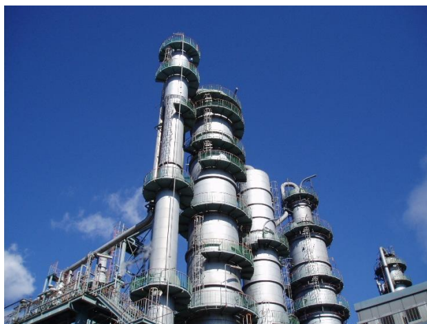
<コアシェル型金－酸化ニッケルナノ粒子触媒を用いたメタクリル酸メチル製造プラント>
