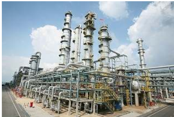
AN 新工場外観
