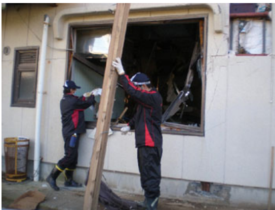
建物内の瓦礫撤去作業
