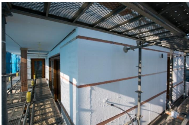
北洲の「プレミアムパッシブハウス」に採用された高性能断熱材「SLENTEX®」
