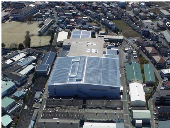
山梨積水の本社・工場の屋根に太陽光発電設備を設置
