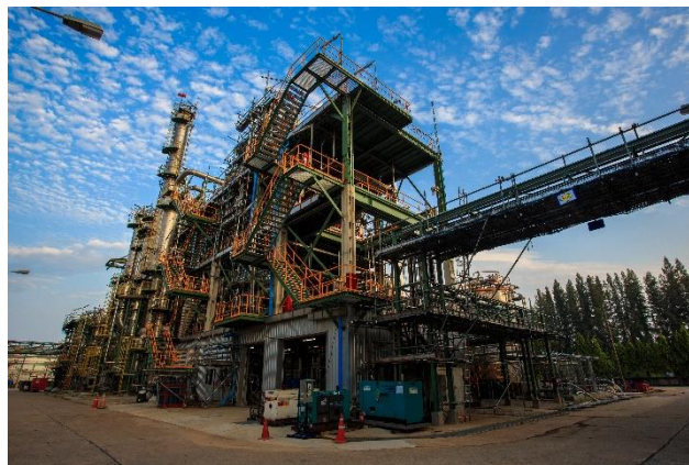
タイで稼働中のPCDI 期製造設備
