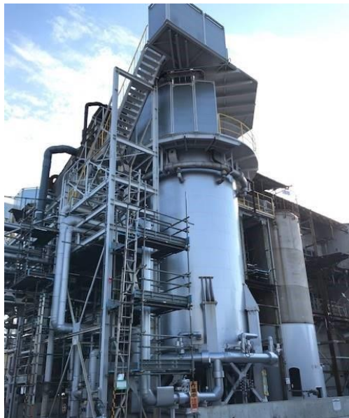
竣工した新培養槽
