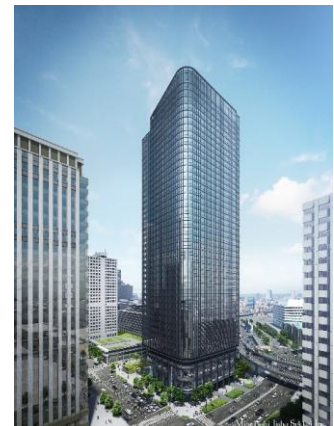
常盤橋タワー
