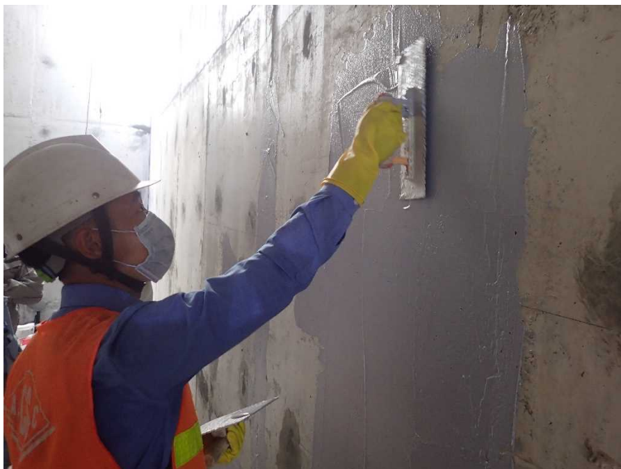
新会社で販売するポリマーセメント系塗膜防水材「アクアシャッター」の施工例
