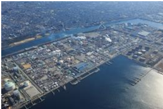
三井化学大阪工場
