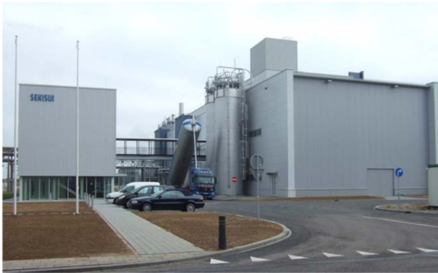
オランダ原料工場の外観
