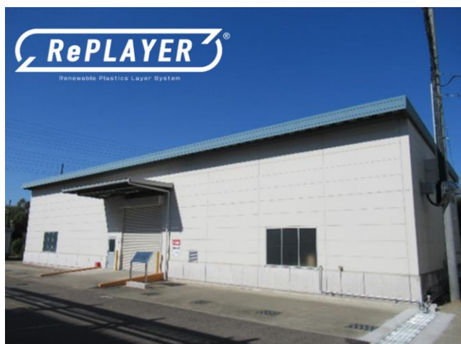
設備建屋外観（名古屋工場内）
