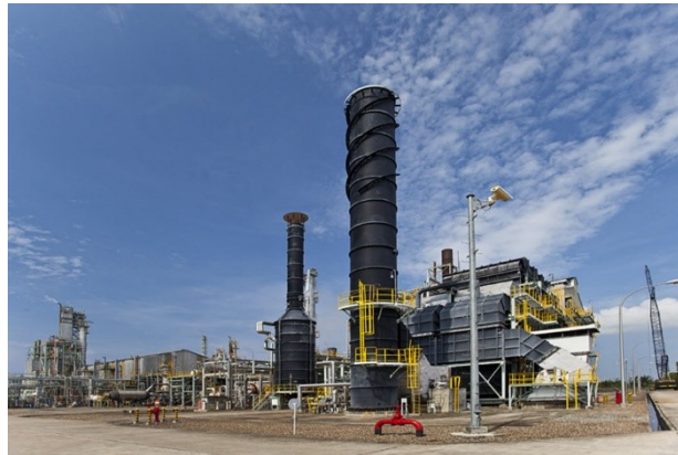
Pupuk Iskandar Muda 社既存肥料工場 プラント全景写真
