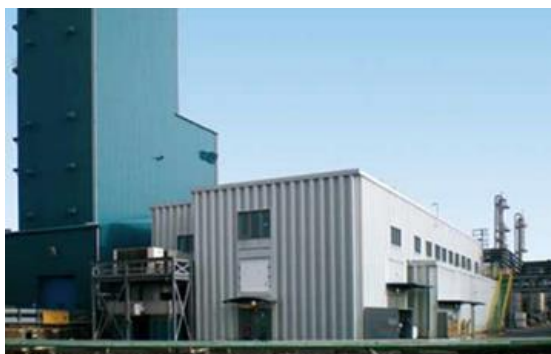
Mitsubishi Chemical UK Ltd. のソアノール™製造拠点
