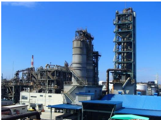
BPAプラント（三井化学 大阪工場）
