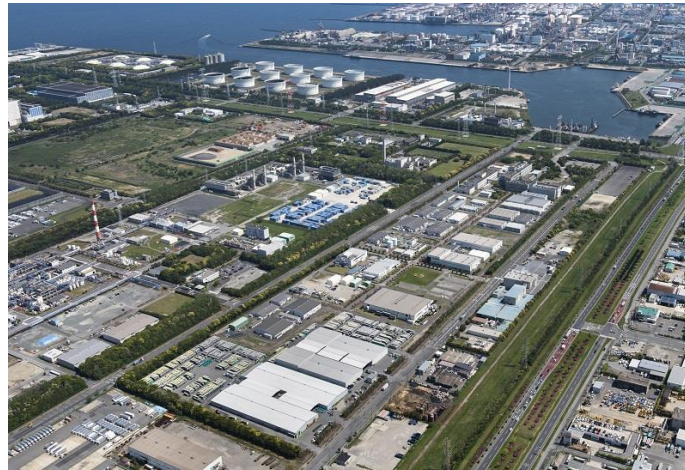
袖ヶ浦センター全景
