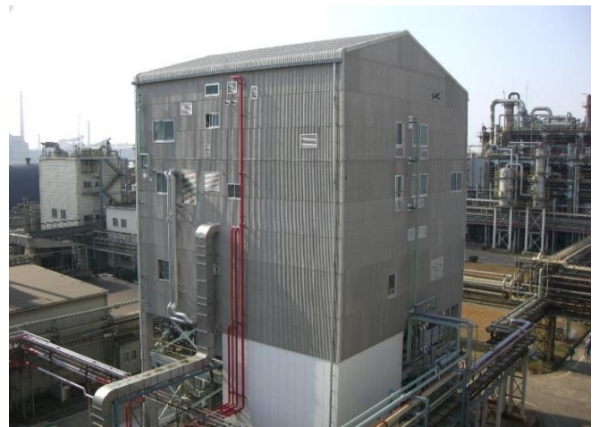
宇部ケミカル工場内の中空糸製造設備（Ⅲ期）
