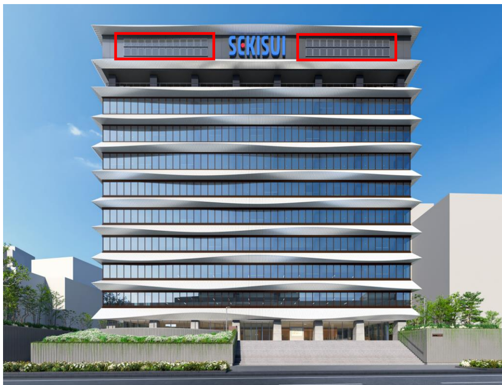
大阪本社 リニューアル完工イメージ (赤枠内がフィルム型ペロブスカイト太陽電池)
