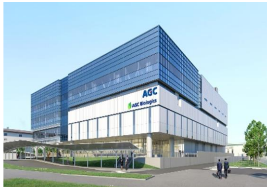
AGC 横浜テクニカルセンターに新設するバイオ医薬品 CDMO の開発・製造施設 (完成予想図)
