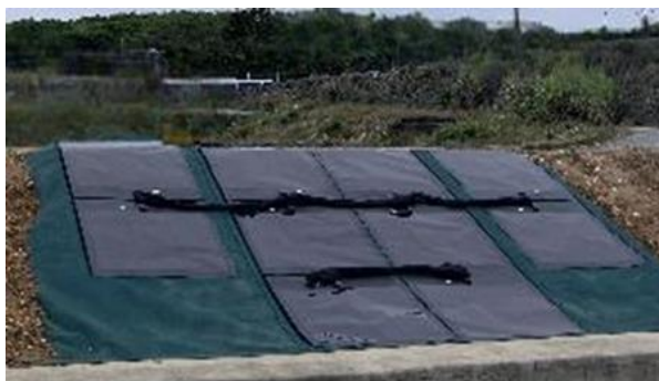
(写真 2) 設置完了したフィルム型ペロブスカイト太陽電池
