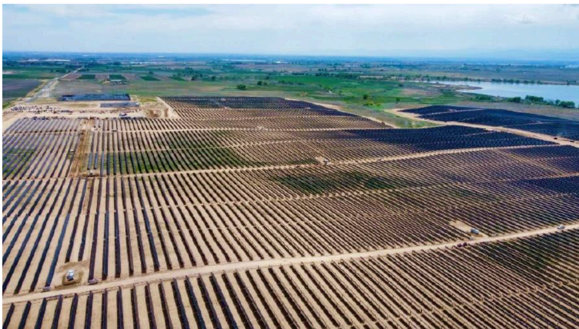
ブラック・ホロウ・サン発電所（プラットリバーソーラープロジェクト）
