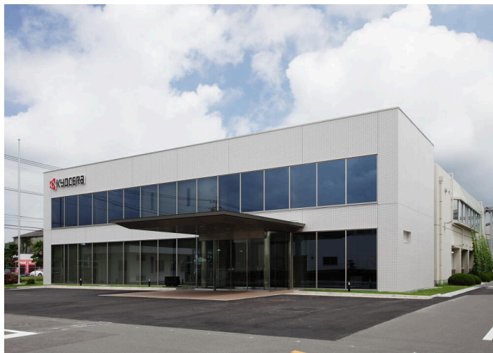
京セラ鹿児島川内工場外観
