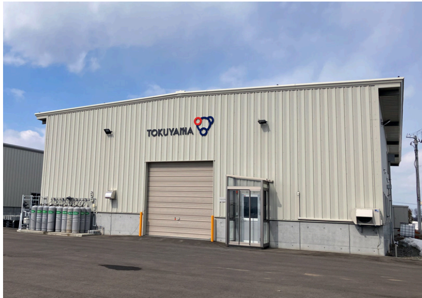
トクヤマ南幌（太陽光パネルリサイクル実証試験施設）
