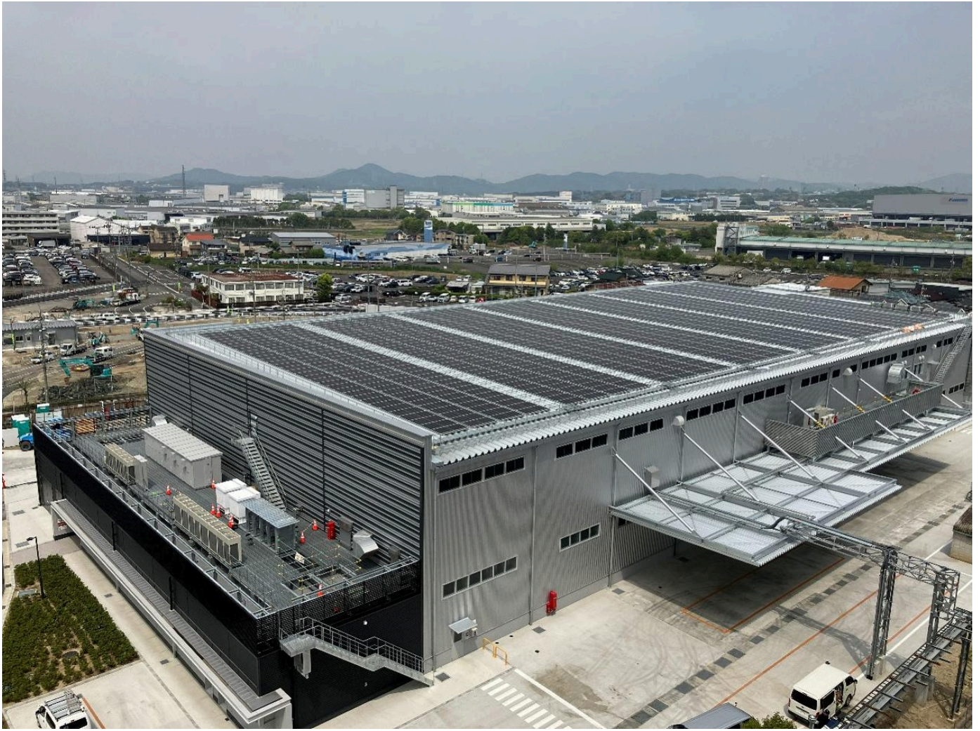
太陽光発電を導入した住友理工・小牧製作所
