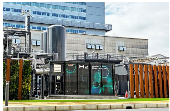
PEM 型水電解装置の実証機（提供：トヨタ自動車）
