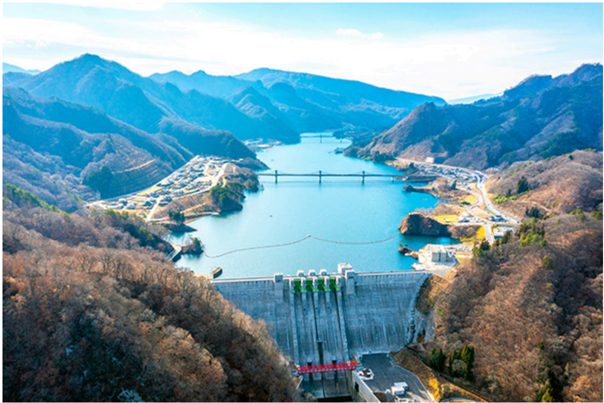
群馬県内の水力発電所
