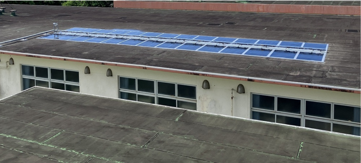
陸屋根への設置
