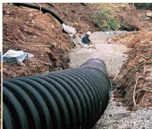
< 土地造成工事 >
