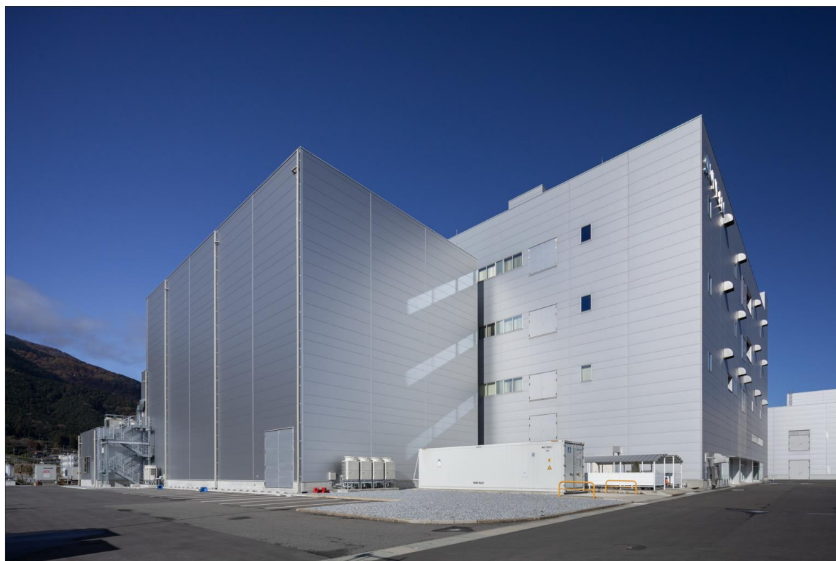
ワクチン原薬製造設備外観
