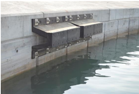
岸壁に設置した V 型ソリッドフェンダー
