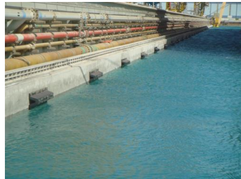
岸壁に設置した V 型ソリッドフェンダー
